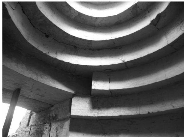
Рис. 23. Плиты перекрытия входа в камеру и уступы купола
